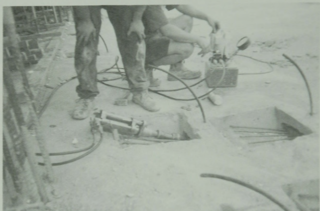
11-12. ábra. Borda kábeleinek megfeszítése
