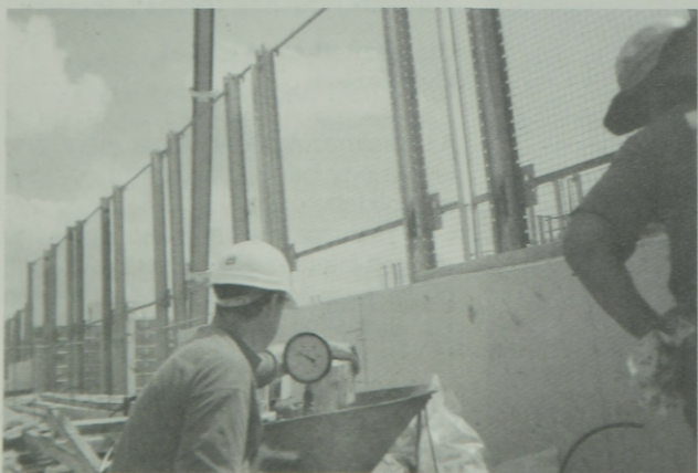
7-10. ábra. Főtartó kábeleinek megfeszítése
