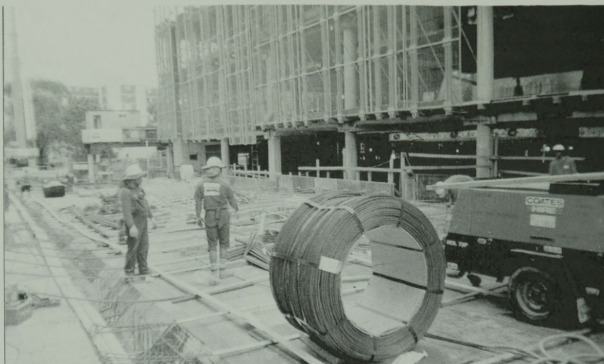
1. ábra. Betonacél szerelési munkák. Előtérben egy tekercs pászma
