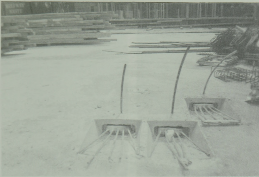
15. ábra. Lehorgonyzófejek az injektáló csövekkel
