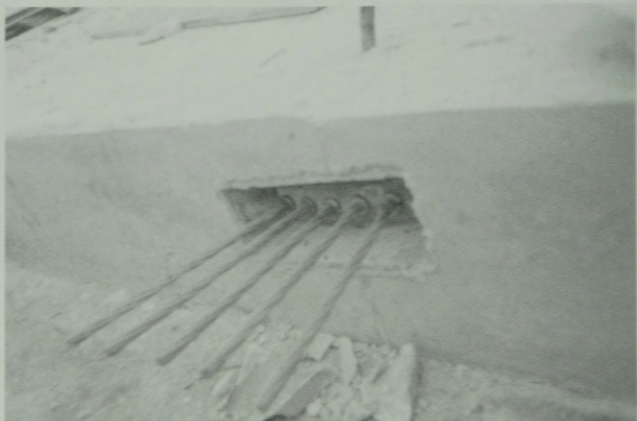
13. ábra. Lehorgonyzófej kiszaluzott állapotban
