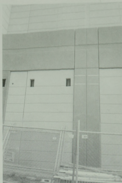
19–20. ábra. A bevásárlóközpont oldalhomlokzata (A fal áttörései az előtetőt tartó konzolok számára vannak kihagyva. Azok akkor kerülnek elhelyezésre, amikor már nem akadályozzák az építést, szállítást, emelést stb.)
