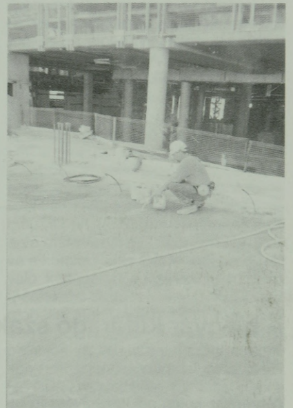
17–18. ábra. A kábelcsatornák kiinjektálása
