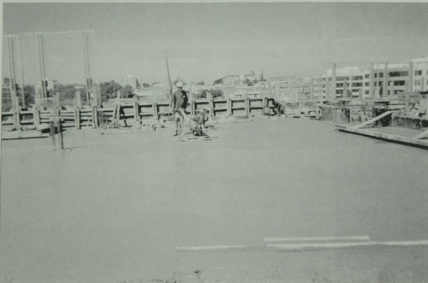
6. ábra. Beton simítása
