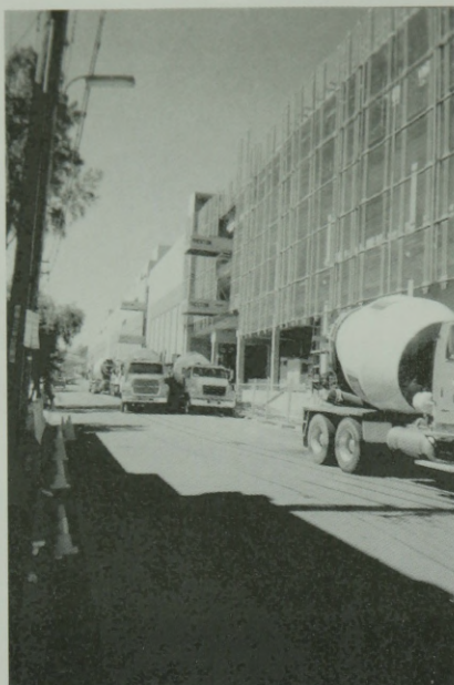
19–20. ábra. A bevásárlóközpont oldalhomlokzata (A fal áttörései az előtetőt tartó konzolok számára vannak kihagyva. Azok akkor kerülnek elhelyezésre, amikor már nem akadályozzák az építést, szállítást, emelést stb.)
