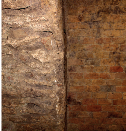
12. ÁBRA: Tégla és kő falazat csatlakozása
