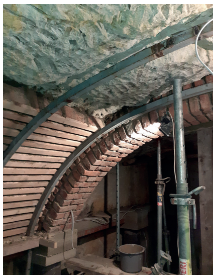
3. ÁBRA: Pinceépítés bányász technológiával [2]
