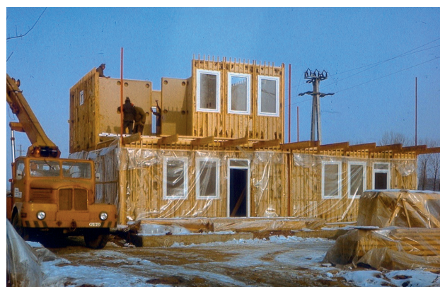
2. ÁBRA: Az első hazai emeletes, kispaneles faház
