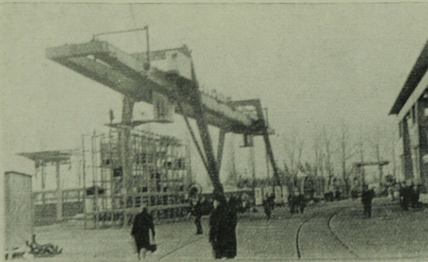
8. ábra. Kettős szekrénytartós korszerű bakdaru
