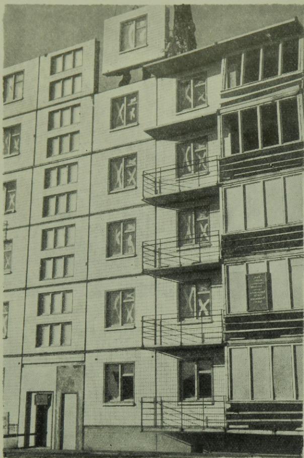
21. ábra. Kilencszintes hosszsfalaz panelház szerelése
