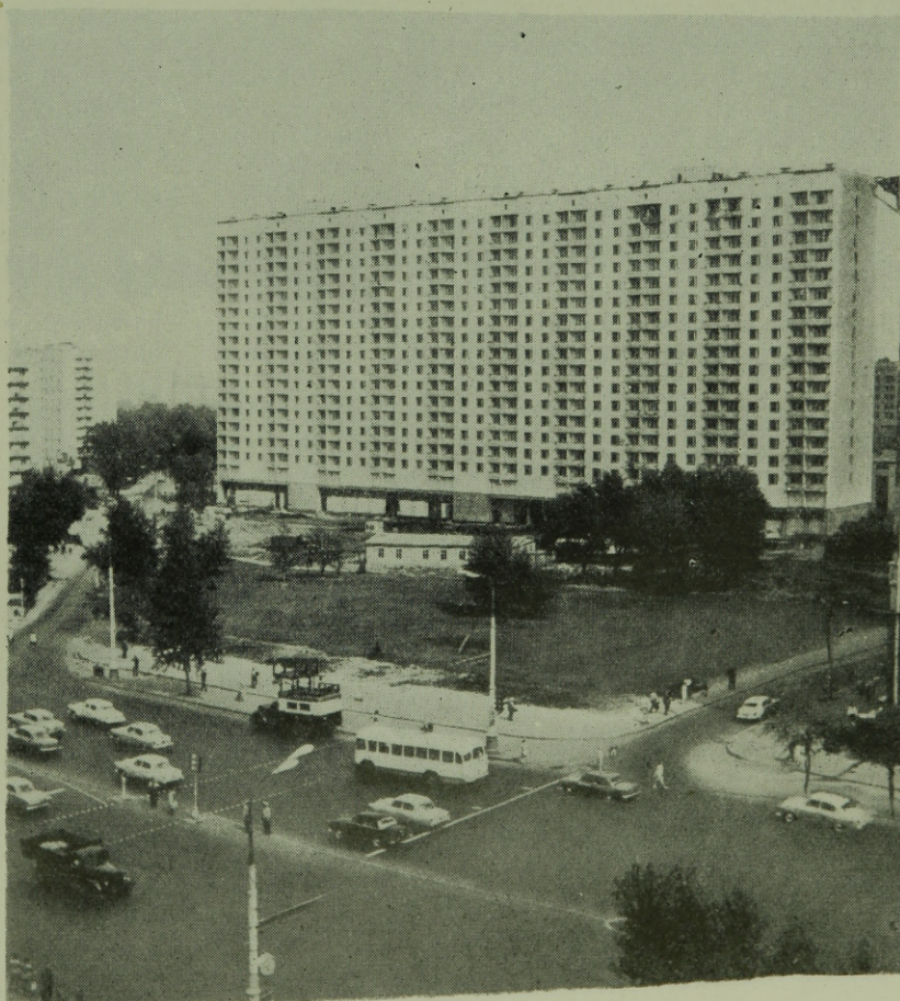
1. ábra. Moszkva, 54 m magas, 17 emeletes, 400 lakásos épület a Béke sugárúton
