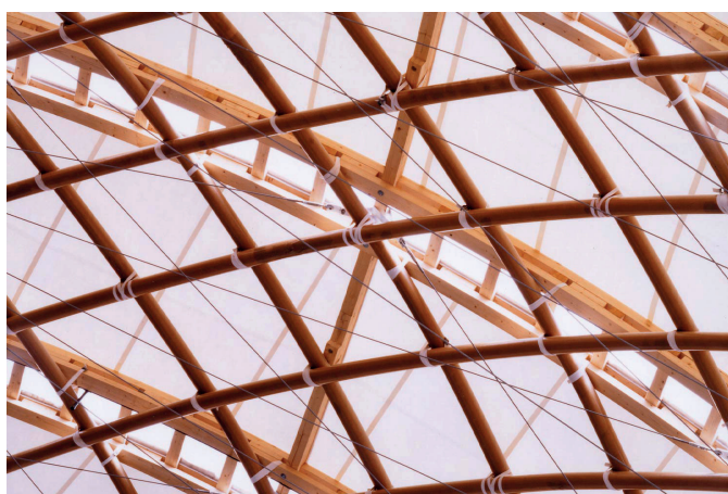
5. ÁBRA: A 2000-es hannoveri világhíallítás japán pavilonjának szerkezetét papírcsövekből kialakított térrács adja, Shigeru Ban terve alapján [20]
