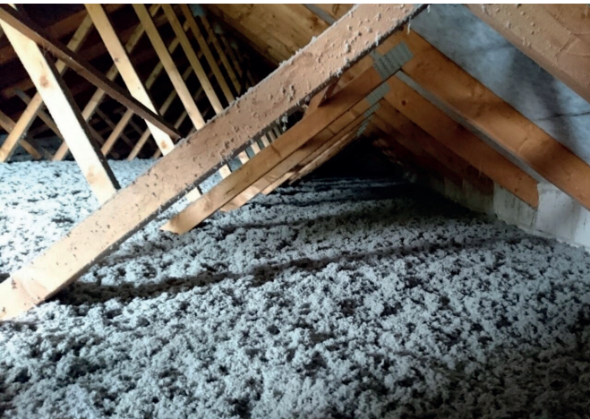
6. ÁBRA: Cellulóz hőszigetelés alkalmazása padlásfödemen [25]
