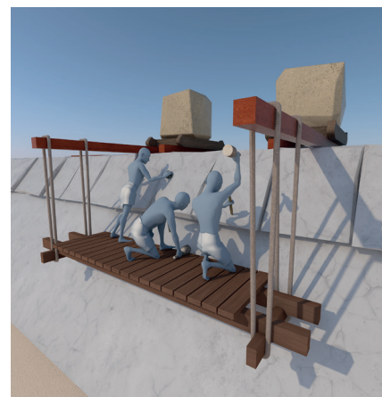
6. ÁBRA: A turai, fehér mészkő burkolat formázása és csiszolása
