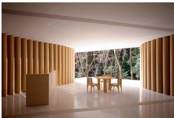
4. ÁBRA: Shigeru Ban 1995-ben tervezett papírháza, melyben a papírcsöveket tartószerkezeti elemként használta [19]
