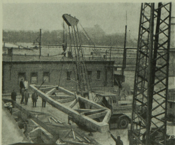
2. ábra. Főtartó felszakítása
