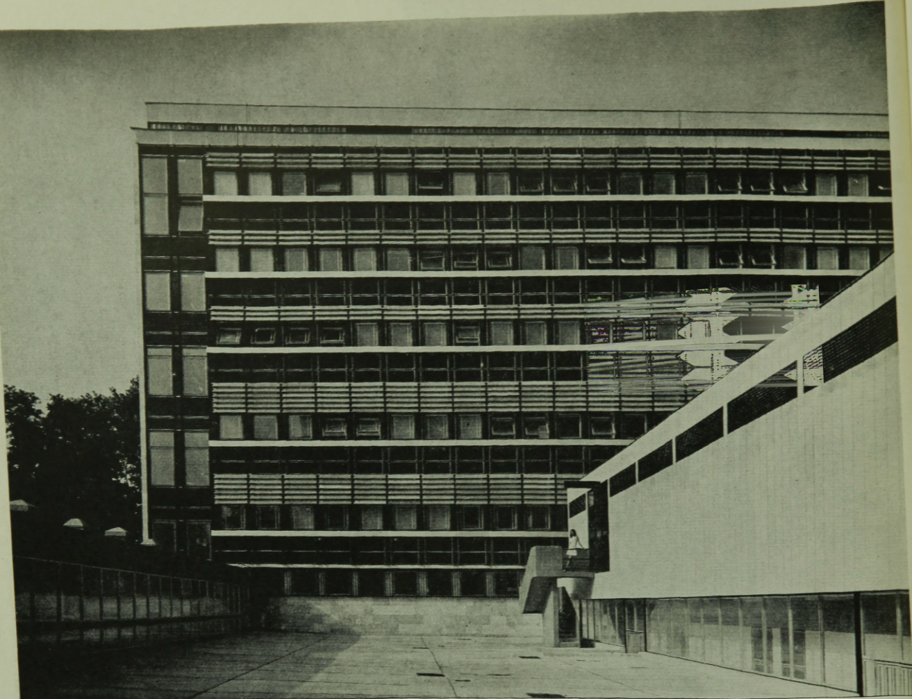
KLTE Kémia épület — szerves kémiai intézetek a belső udvarból
