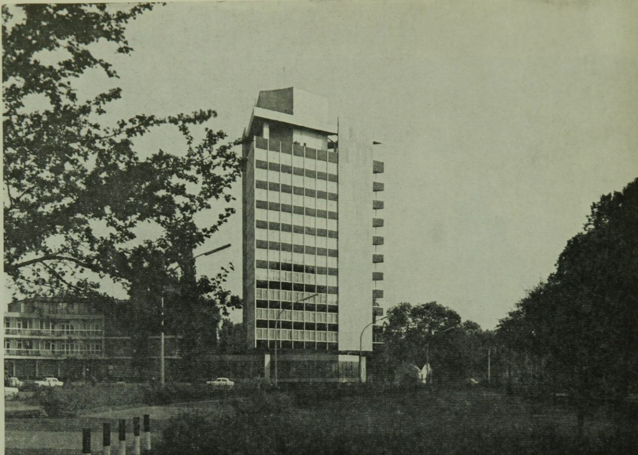
Debrecen, Nagyerdei Vasas üdülő homlokzata
