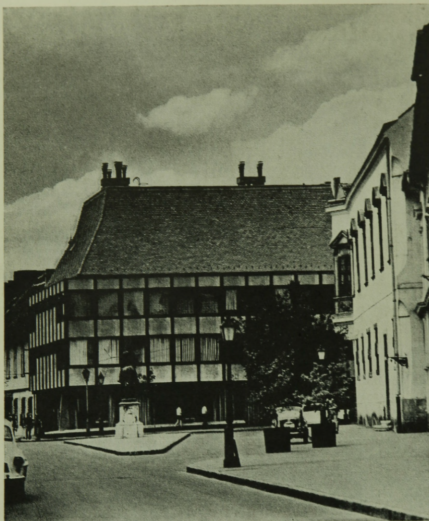
Az épület homlokzata
