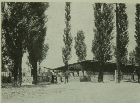
25. kép. Fogasos strandöltöző épület Balatonbogláron
