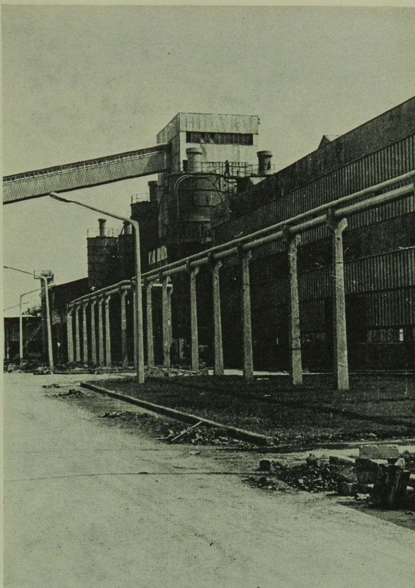
5. ábra. Főgyártócsarnok, mellette a betongyár a felhordó szalaggal és cementsilókkal
