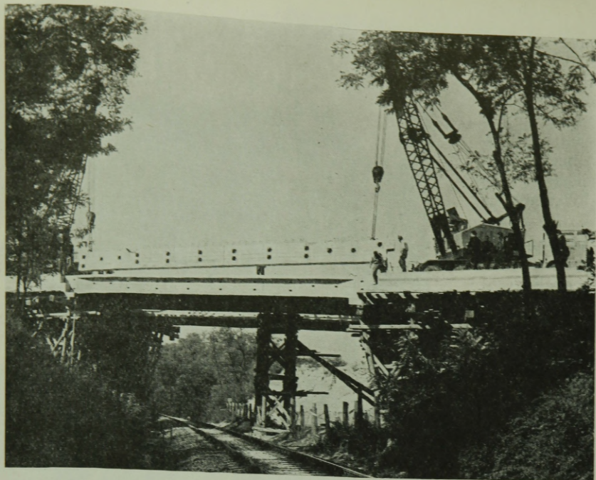
7. kép. Utófesztett tartók beemelése (Hidépítő Vállalat gyűjteményéből)
