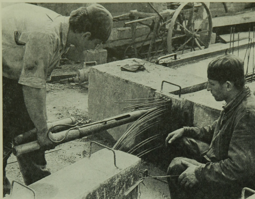
9. ábra. Egyhuzal-feszítősajtó a TT tetőelemek gyártásánál
