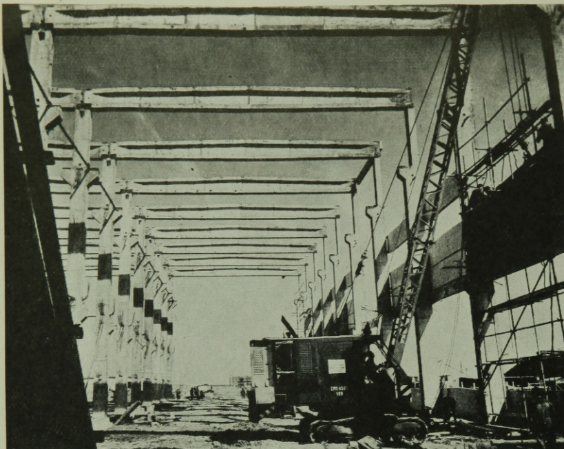
13. ábra. 18 m fesztávolságú elemekből feszített főtartó
