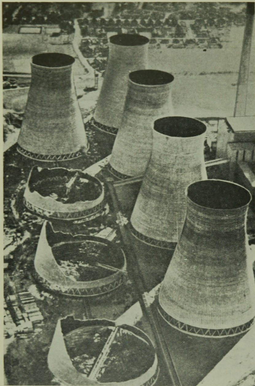
5. ábra. A tornyok a szélelles irányban omlottak össze
