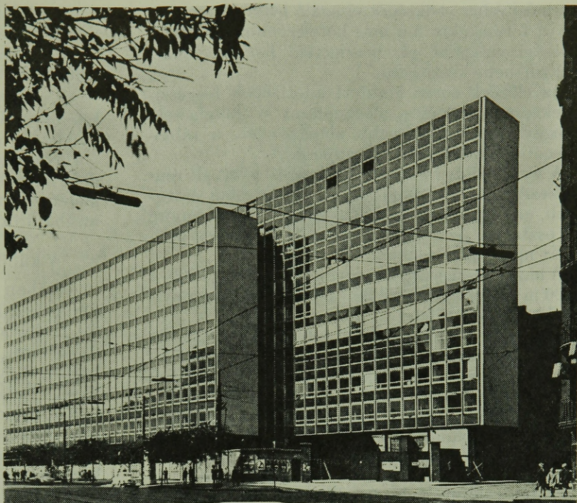
6. ábra. Hőszigetelő üvegezés a most épülő GANZ Székház épületén
