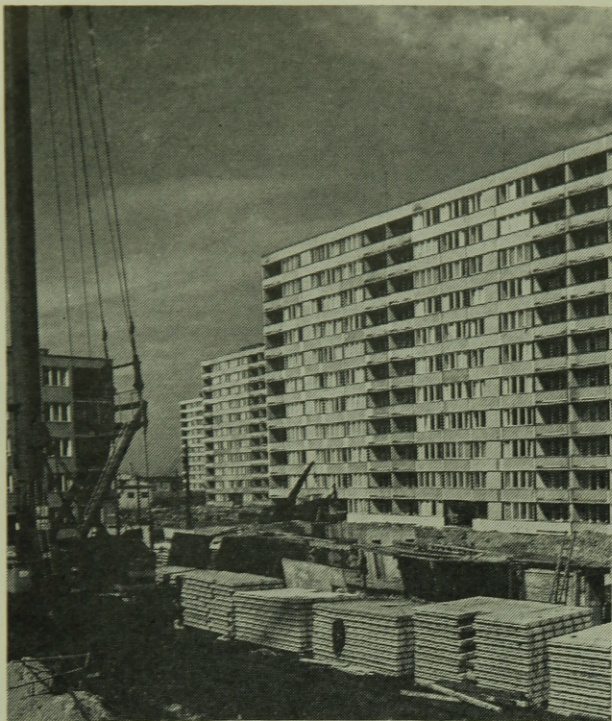
2. felvétel. Fogarasi úti lakótelep 1, 2, 3. jelű épületek (Foto BVTV: Orlay)
