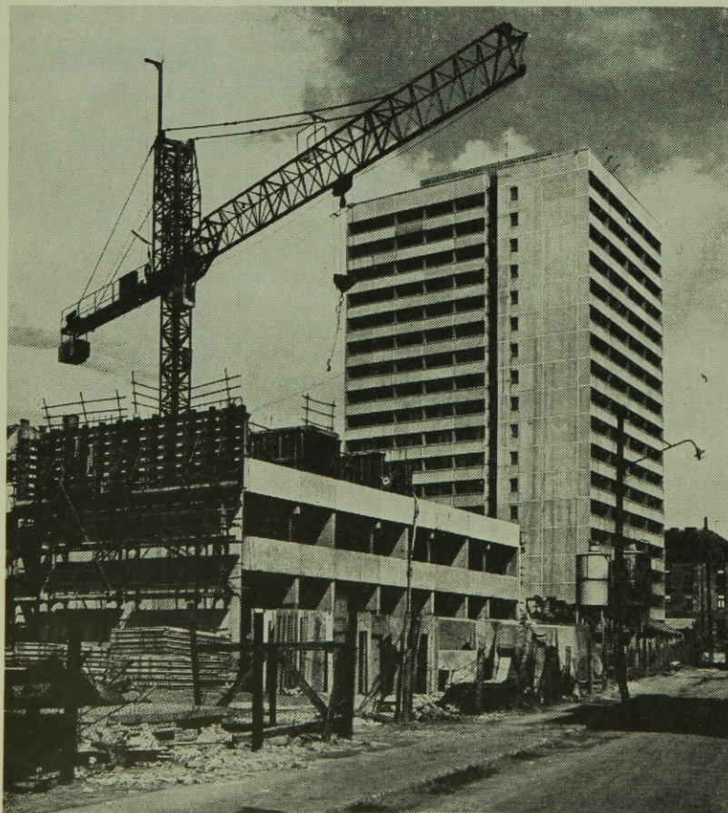
6. ábra. Tömő utcai magas lakóépületek építés közben
