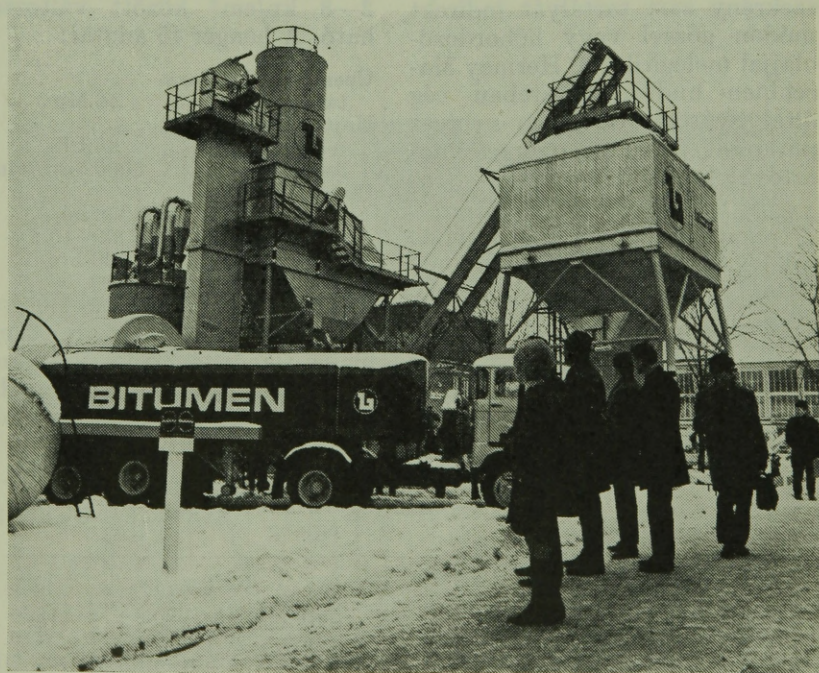
6. ábra. Az aszfaltkeverés géplánca
