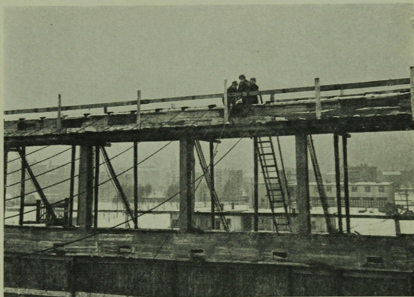
4. ábra. Függesztő rudak elhelyezése
