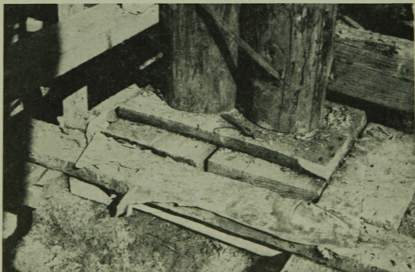
7. ábra. Állványoszlopok felfekvése a pallókkal körülzárt homokágyon. (Nedvességvédelem miatt fóliaréteg)
