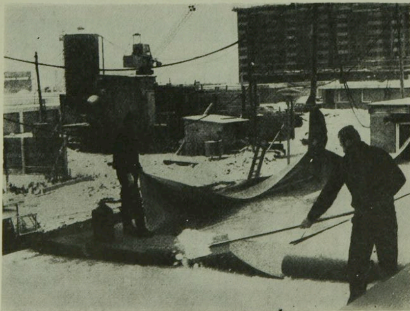
7. ábra. Lapostető szigetelés készítése téli időjárásban, lágy PVC-fóliával
