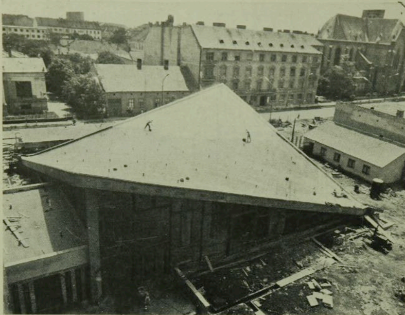
13. ábra. Paraboloid héjtetőszerkezet szigetelése műanyag lemezzel. Ifjúsági ház Békéscsaba). Tervező: Scultéry János ÁÉTI. Anyag: HMV NEOACID lemez. Kivitelezés: ORSZÁK
