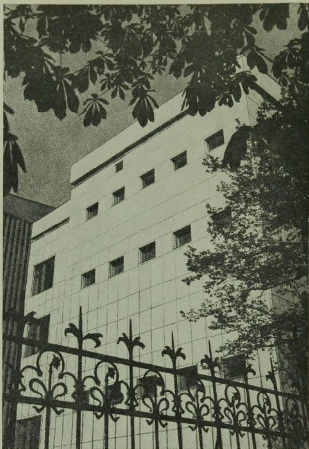
13. ábra. BOTE, pala homlokzat-burkolat
