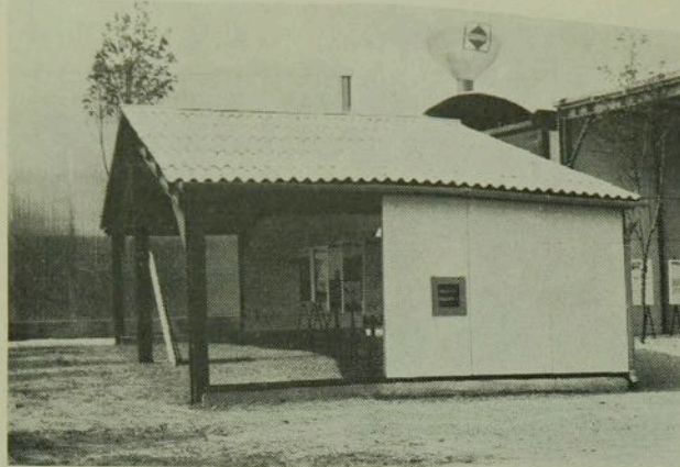
11. ábra. 1970. Mezőgazdasági Vásáron felépített GFT-III. könnyű acél szerkezetű magastető-s változatú kis állattartó épület
