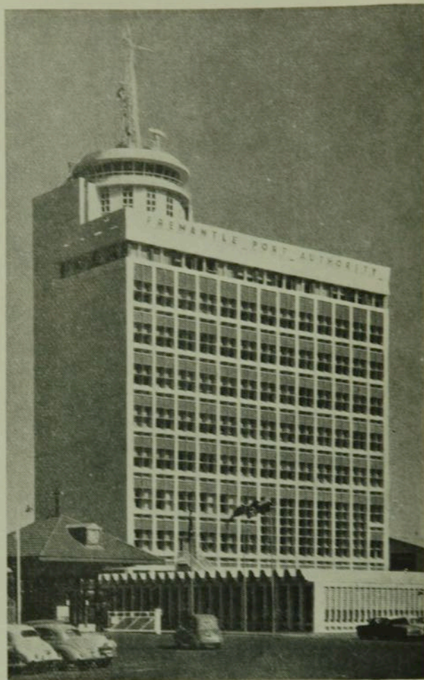
10. ábra. Azbesztcement parapetburkolatú épület (Ausztrália)
