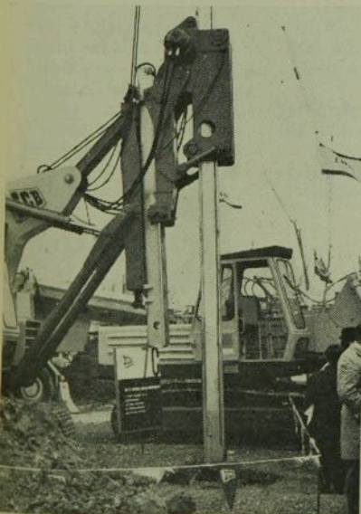
17. ábra. JCB aknamélyítő markoló
