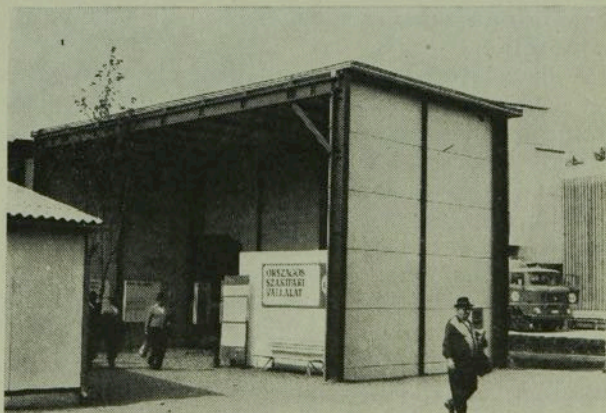
10. ábra. 1970. Mezőgazdasági Vásáron felépített GFT-III. könnyű acél szerkezetű hűtött tároló egység (25 vagonos)
