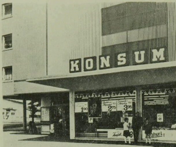
14. ábra. LUXAFLEX burkolatú lakóépület homlokzati részlete (NSZK)
