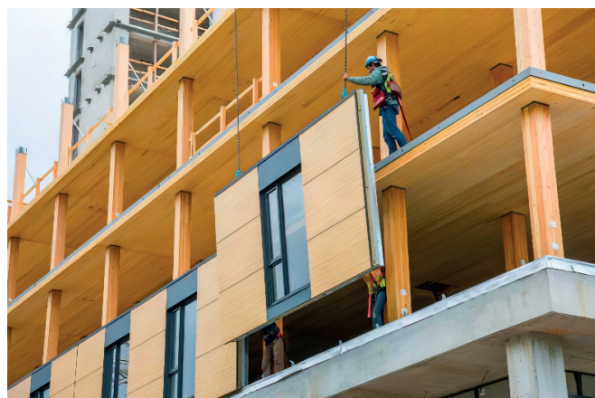
2. ÁBRA: Magasház építés Kanadában glulam és CLT technológiával [4]
