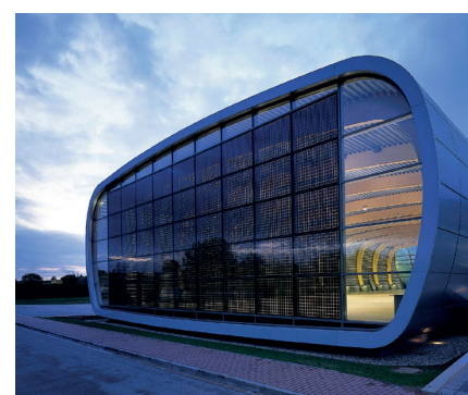
5. ÁBRA: Függönyfalszerkezetbe integrált napelem axonometrikus rajza (saját ábrázolás) [4] és fényképe [7] (Tobias Grau GmbH, Rellingen – tervező: Hadi Teherani Architects GmbH)
