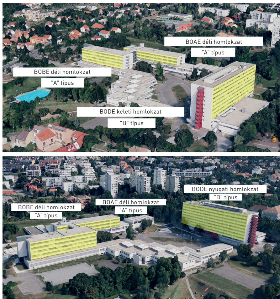
6. ÁBRA: Madártávlati képek a napelemmel telepített homlokzatokról (saját ábrázolás)
