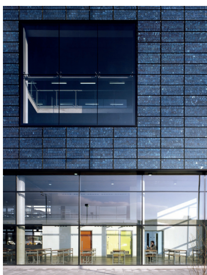
4. ÁBRA: Szerelt homlokzatburkolatba integrált napelem axonometrikus rajza (saját ábrázolás) [4] és fényképe [6] (Manchester College of Art & Technology, tervező: Walker Simpson Architects)
