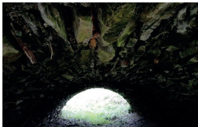
8. ÁBRA: 8-10 cm mély fugahiány a pulai híd intradoszán (írvastagság 40 cm)
