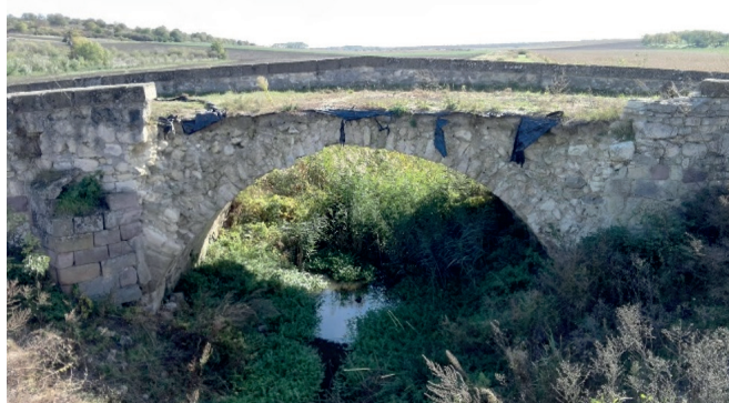
3. ÁBRA: A héhalmi híd tönkremenetele
