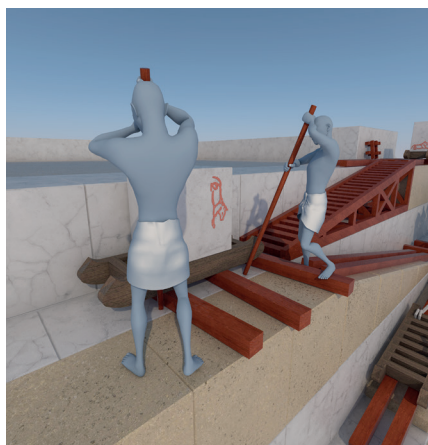
4. ÁBRA: Egy 2500 kg-os kő oldalirányú eltolása feszítő rúddal
