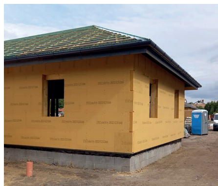
8. ÁBRA: Lakóépület homlokzati hőszigetelése vakolható farost lapokkal
