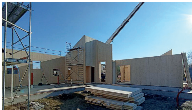
7. ÁBRA: CLT falas épület építése
