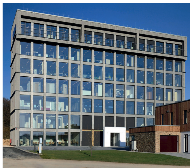
4. ÁBRA: Kampa építőipari innovációs központ, Aalen, 8 szintes faépület [6]
