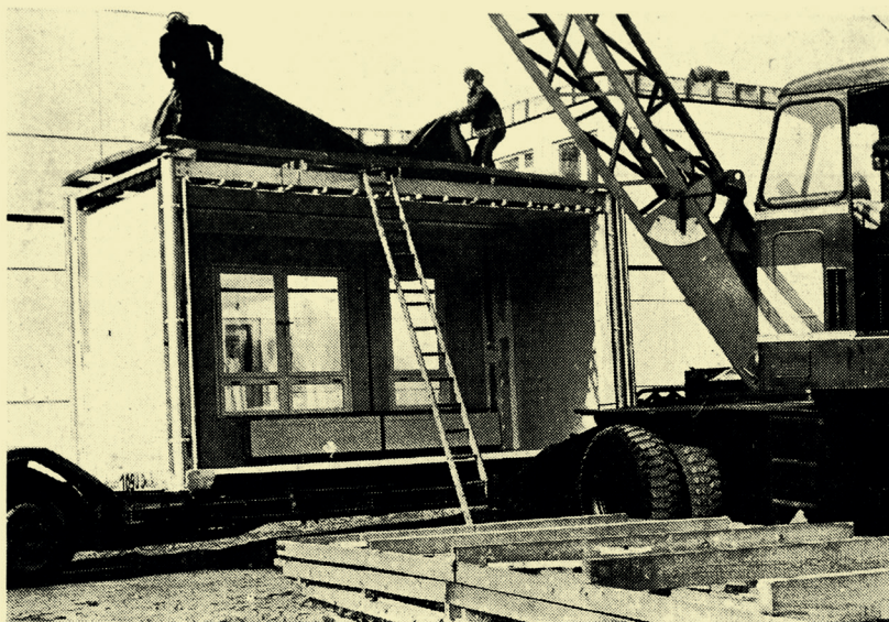
1. ábra. Az építéshelyre kiszállított „Dresden 2” típusú térelem előkészítése beemeléshez
