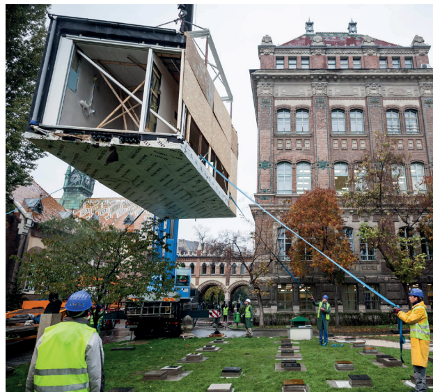
3. ÁBRA: A 2012-es Solar Decathlon versenyen kitűnően szereplő Odoo ház első moduljának beemelése a Műegyetem kertjébe (fotó: OdooProjekt)
