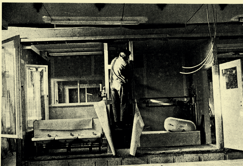
2. ábra. Térelem szak- és szerelőipari munkáinak 85—90%-át a futószalagon elkészítik
