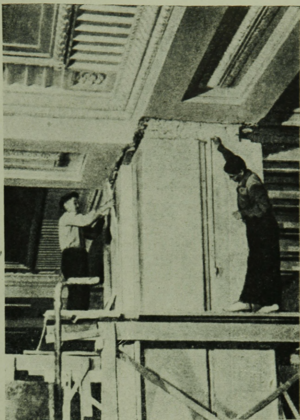
Diszító munkák a Moszkvai Állami Egyetem főépületének központi részén Отделочные работы внутри центральной части главного здания МГУ. Ornement sur la partie centrale du bâtiment principal de l'Université d'État à Moscou.
