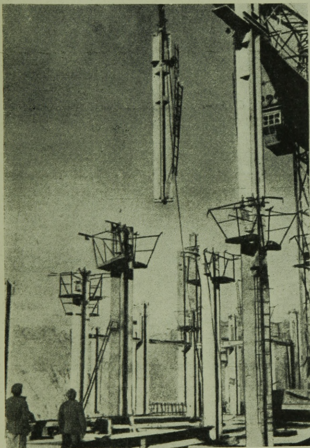
A váz oszlopainak szerelése Монтаж колонн каркаса. Montage des colonnes de l'ossature
