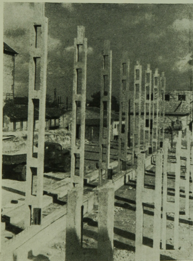
A kétszintes csarnokrész felállított pillérei
