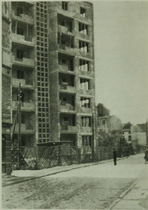
2. ábra. Öntött-technológiával készített pontház Gdanskban
