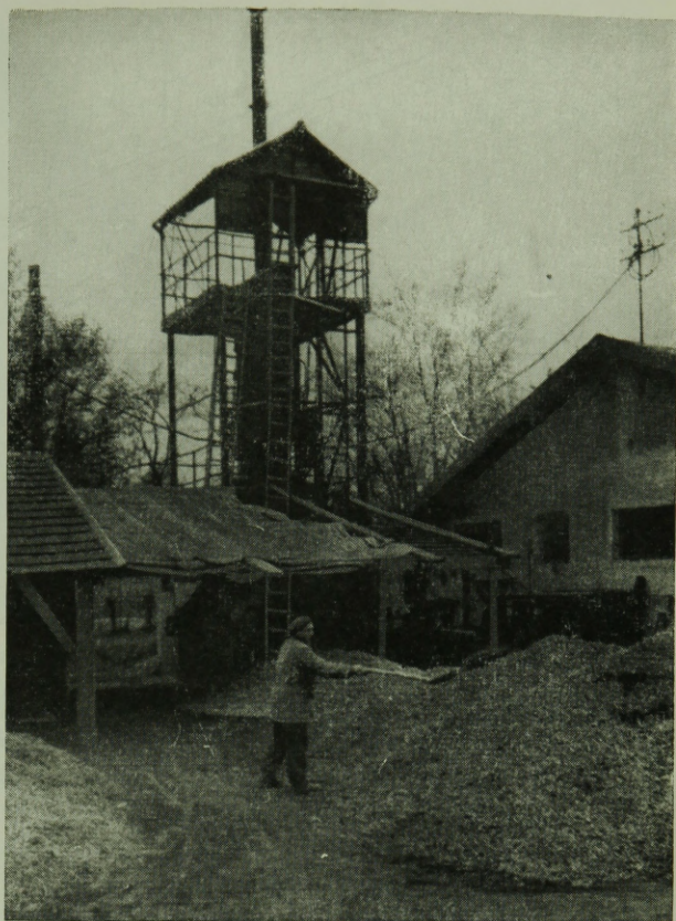
2. ábra. Pernyekavics égető kísérleti kemence
