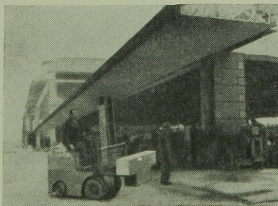
9. ábra. Abingdon: Repülőgéphangár, emelés közbeni kép
