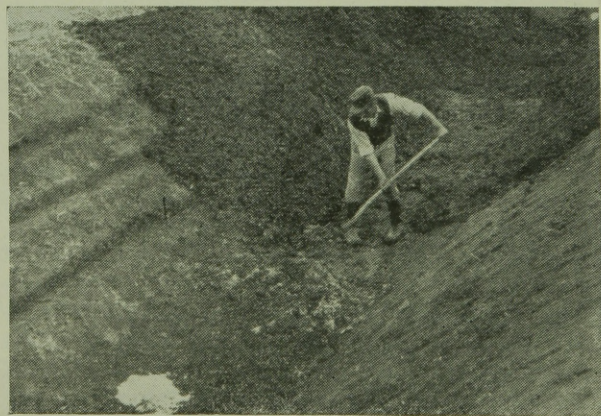
1. kép. Bentonit és talaj megkeverése
