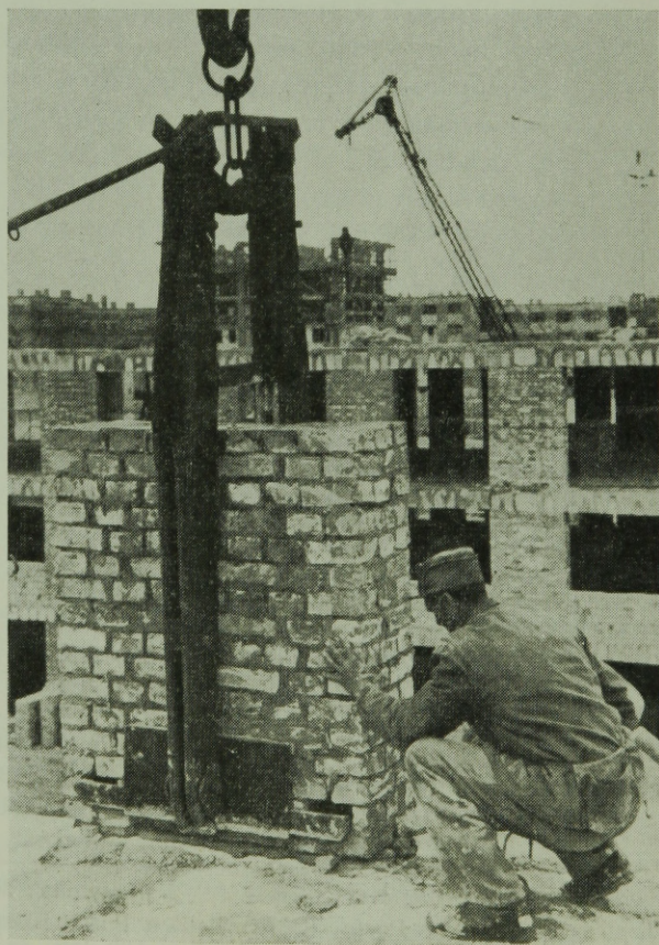
9. ábra. Téglablokk elhelyezése ékekkel
