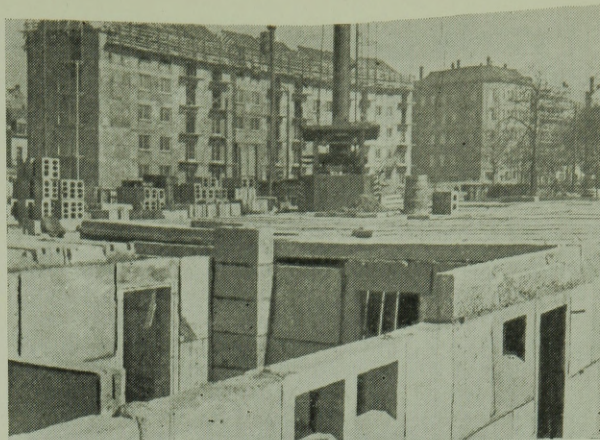
18. ábra. Előregyártott alapfalblokkok kavicsbetonból Lipseben. Háttérben befejezés alatt levő középblokkos lakóház
