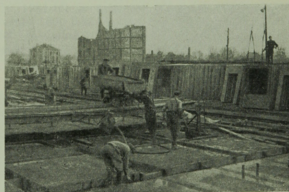
1c ábra. A kavicsbeton nyíláselemeket fekvőgyártással készítik. A betonozás mozgó munkahídról történik
