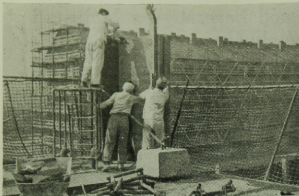
2. ábra. Könnyűbeton nagyblokk sarokelemek elhelyezése Drezdában. Az épületet a biztonságtechnikai előírások szigorú betartása mellett szerelőbrigád állítja össze
