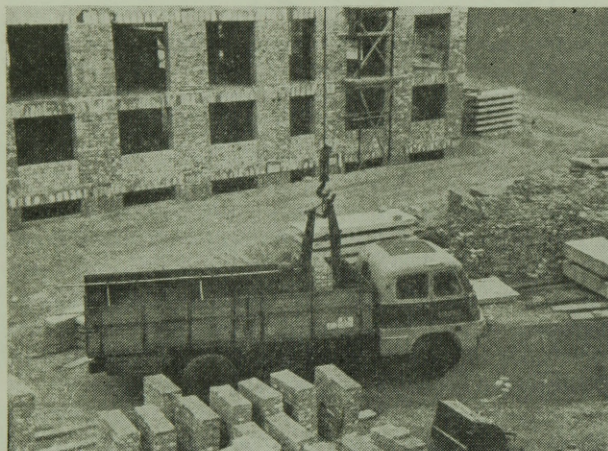
6. ábra. Téglablokk leemelese a szállító kocsiról
