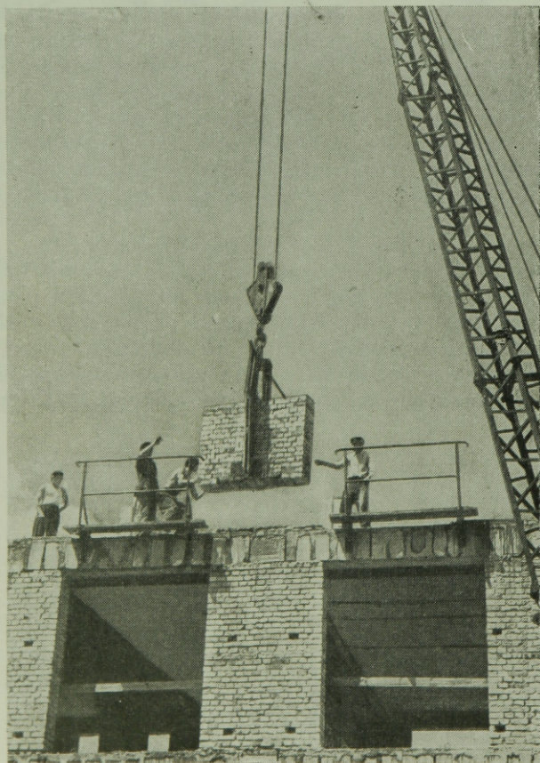
7. ábra. Téglablokk beemelése
