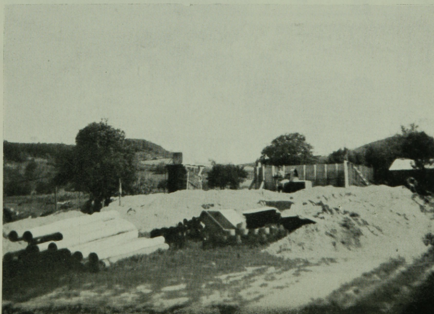
Balatonfüredi vízműbővítés medenceépítése
