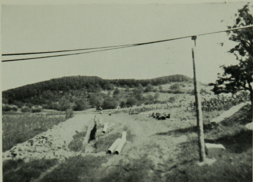
Balatonfüredi vízműbővítés nyomócsőfektetése
