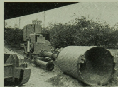
18. fénykép. Csősajtoló berendezés
