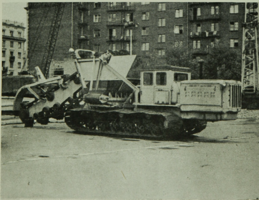
12., 13. fénykép. Pneumatikus vezérlésű árokászó gépek
