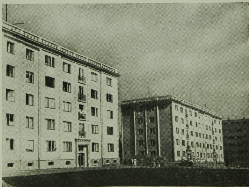
7. ábra. „G” rendszerű panelvázás épületek Prágában
