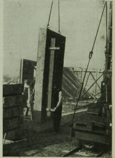
13. ábra. Panelek elhelyezése a talpgerendán
