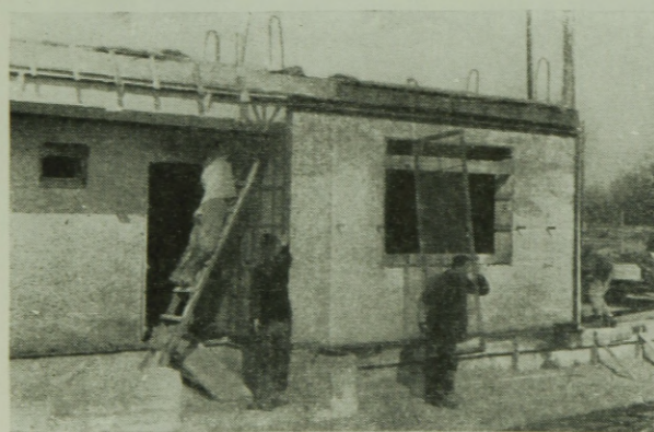
14. ábra. A zsaluzat bontása
