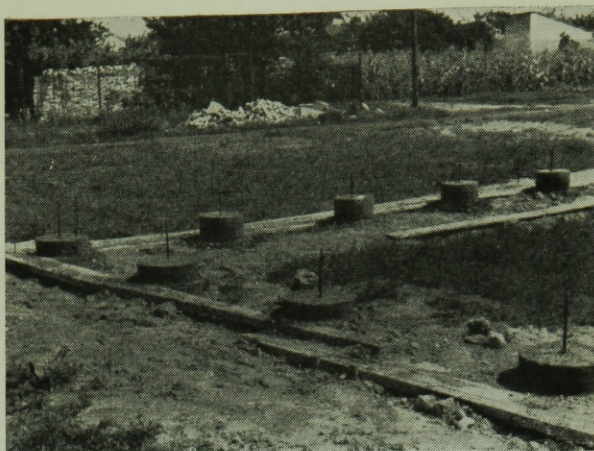
11. ábra. Fűtőcölöpalapozás
