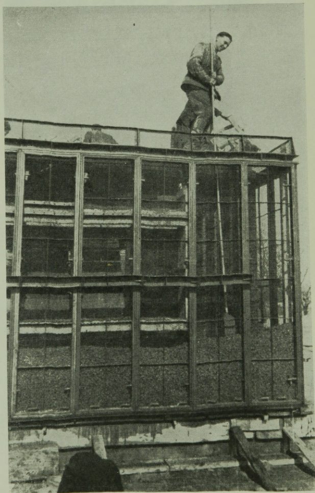
12. ábra. A fal öntése és döngölése
