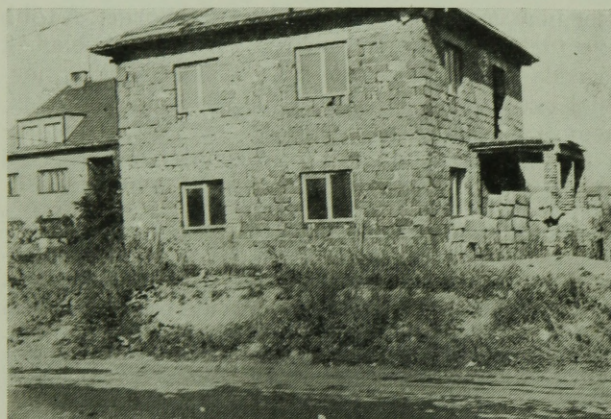
3. ábra. Kézi falazóblokkból épült lakóház az NDK-ban
