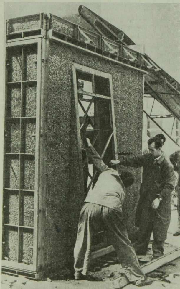
3. ábra. A fém nyílászsaluzókeret nehézkes kiemelése laboratóriumi kísérletnél
