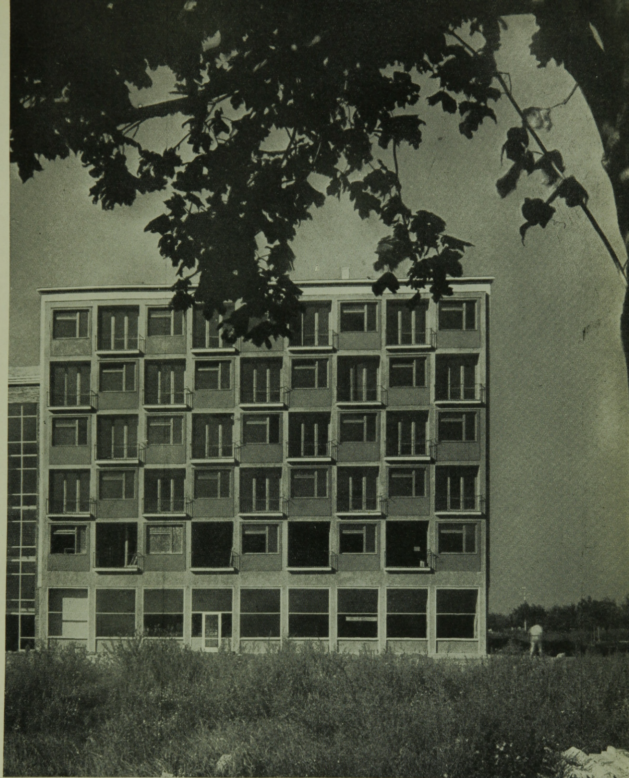
A 30/b jelű épület homlokzata
