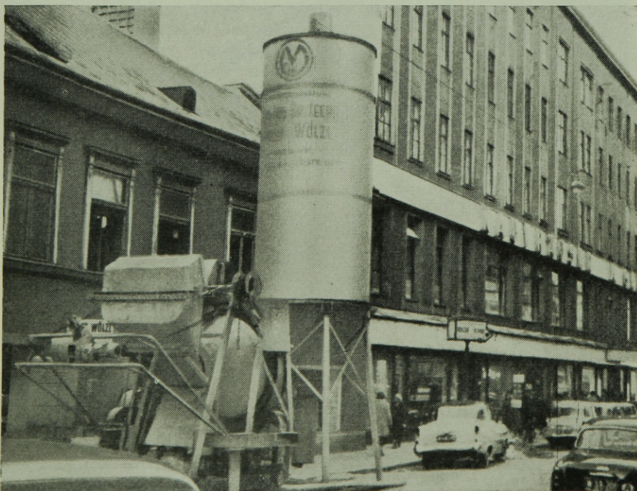
6. ábra. Bécsi építkezés cementsilója
