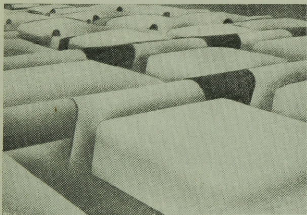
1. ábra. A betonozáshoz előkészített műanyagzsaluzat
