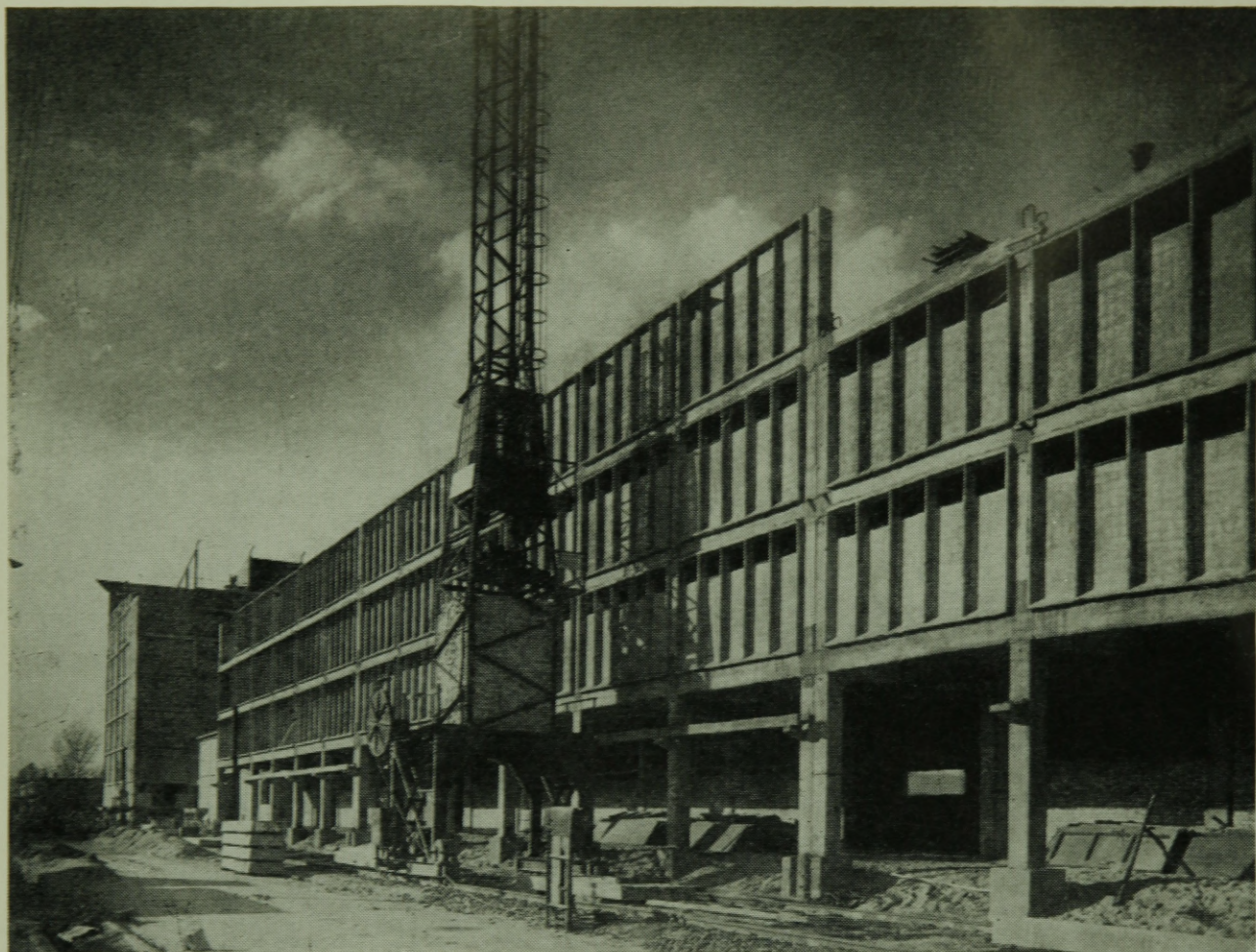
9. ábra. Falpanelek elhelyezése
