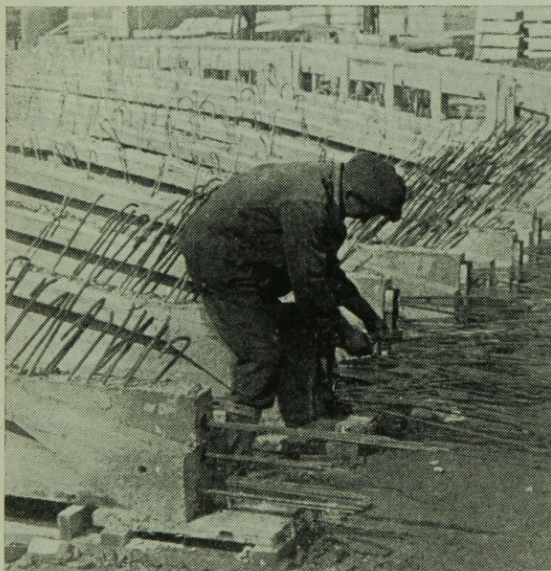
8. ábra. A kábelvég rögzítése a fix oldalon
