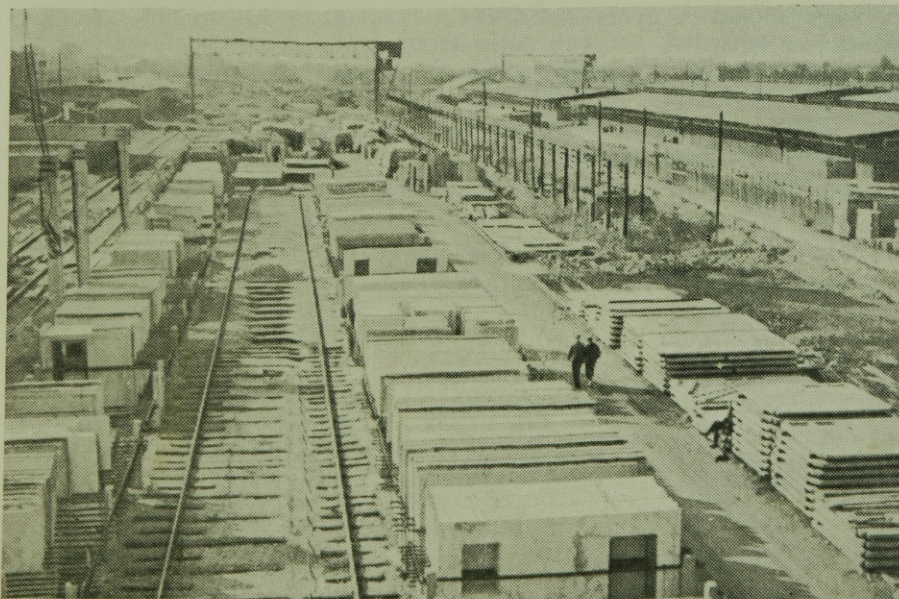
20. ábra. Elemraktározó telep általános látképe. Előtérben toronydarupálya látszik, amely az elemek raktározását szolgálja ki. A háttérben látható portáldaru a nagyelemek gyártásához szükséges
