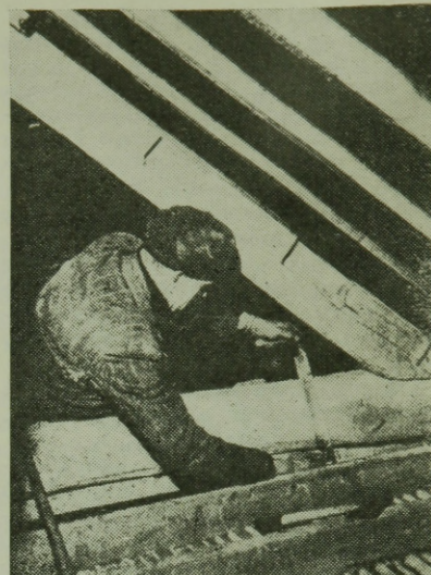
11. ábra. Rovarrágott felületi részek eltávolítása
