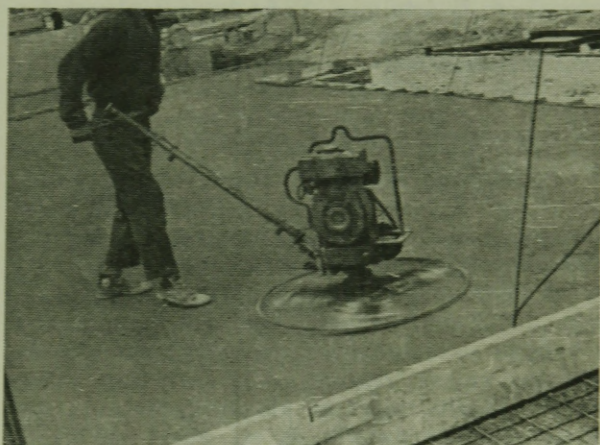
24. ábra. Forgótárcsás vibrátor munka közben
