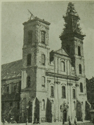
1. ábra. Belvárosi Főplébánia templom helyreállítás előtt
