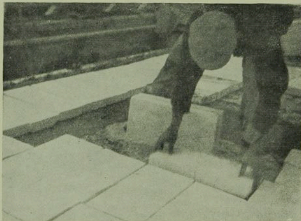
8. ábra. Habüveg hőszigetelés elhelyezése a külső falpanelen
