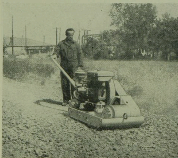
8. ábra. 5 t tömörítőképességű, 700 kg önsúlyú vibrodöngölő (A. B. G.)
