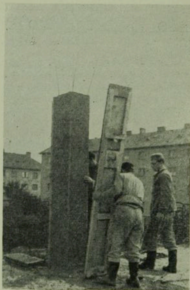
14. ábra. Pillér zsaluzat eltávolítása vákuumozott vázszerkezetű lakóház építésénél
