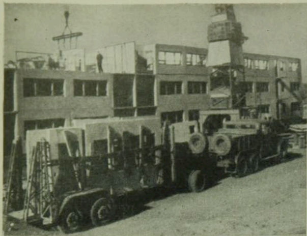
9. ábra. Nagypaneles épület elemeinek szállítása és beemelése
