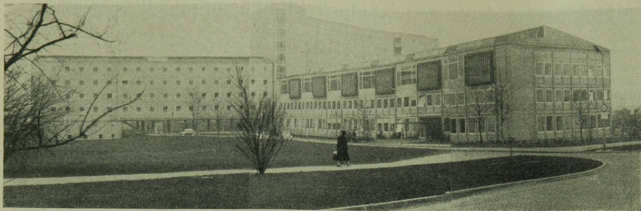
2. ábra. Düsseldorf sebészeti klinika. Észak-keleti homlokzat. Műtő-szárny. Főbejárat. Háttérben a nyolcemeletes nyugati és a négyemeletes keleti fektetőszárny. Ez előtt az auditorium látszik
