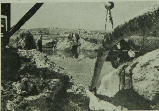
4. ábra. A gázvezetéknek a Sajó medrébe süllyesztése
