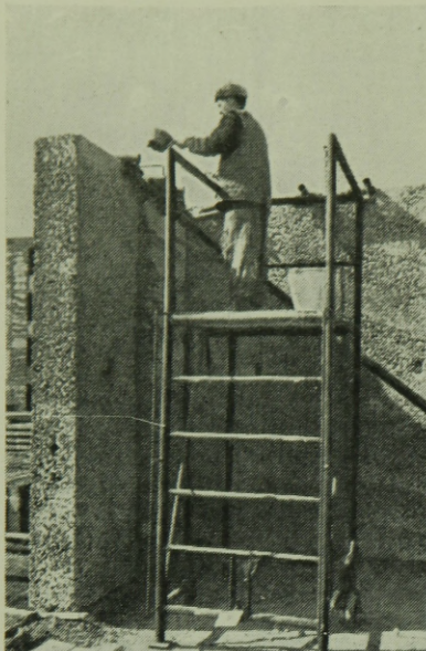
d) A nagyblokkok horonyesatlakozásainak kiöntése
