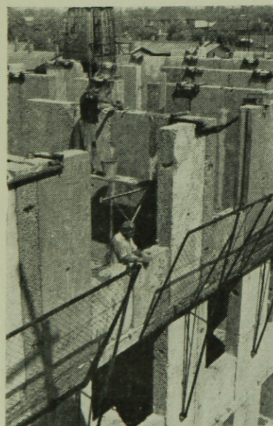
e) Csősapkák és védőháló a falblokkok elhelyezésénél és ideiglenes összefogásánál.
