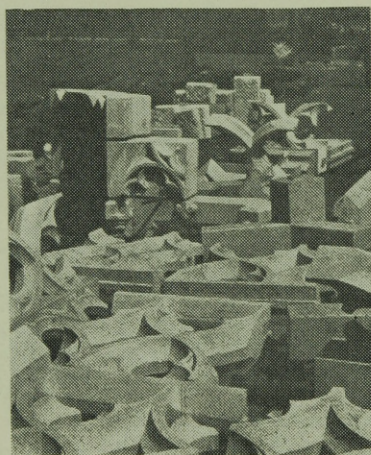
4. ábra. A gótikus mérmű köegységeit először a földön állítják össze. (Mátyás-templom — süttőharaszti mészkő)
