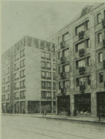
18. ábra. Üllői úti lakóházakon a kőburkolat kombinálva van majolika lappal és fémbetétekkel
