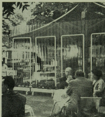
12. ábra. Plexiglas külső térelhatároló fal: kerekéken gurítható műanyag hullámlemez
