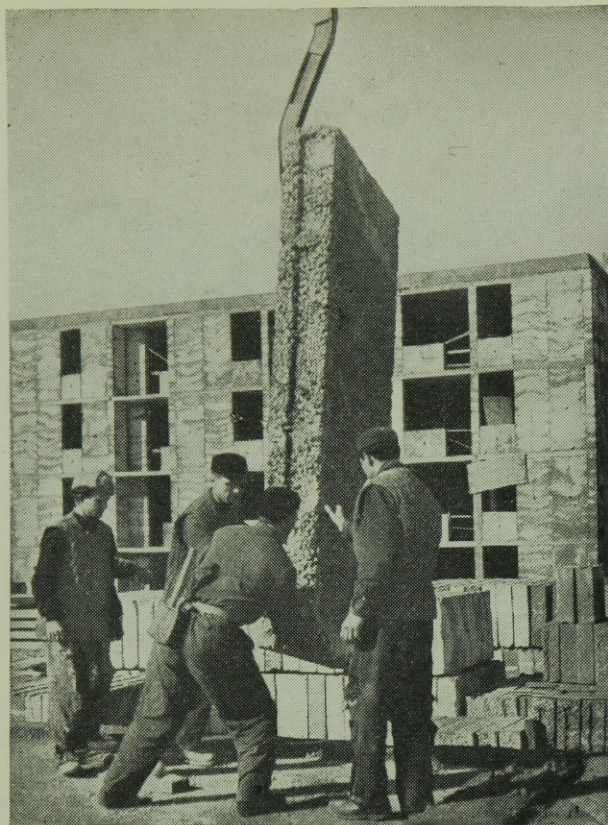
Kohóhabsalak nagyblokk elhelyezés köldökesapos beemeléssel
