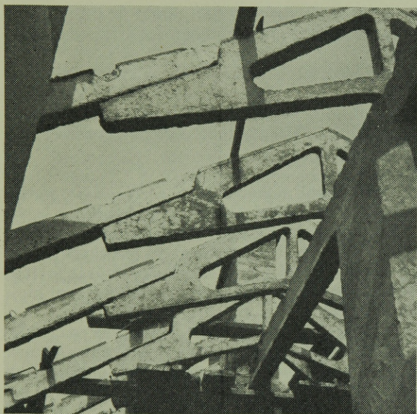
Vb. fedélszék építése
