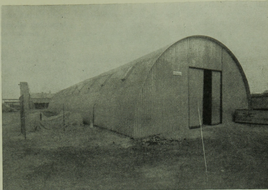
1. ábra. A félköríves hullámlemez fedésű csővázas hangár barakk
