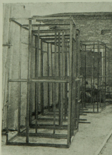
8a, b, c ábra. Szovjetunióbeli előregyártott fürdő és WC fülke vasváza, szerelőaknája és belső berendezése
