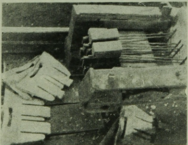
4. ábra. Feszítőhuzalok Magnel rendszerű ékekkel való befogása
