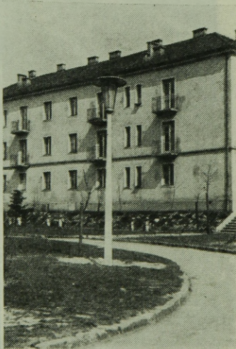
14. ábra. Előrefeszített vasbeton közvilágítási oszlop
