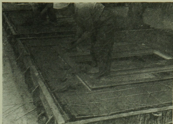
2. ábra. Moszkvai 1. sz. házépítő kombinát. Külső önhordó falpanelek gyártása konvejer szalagon
