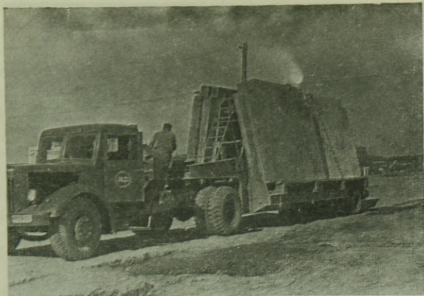
5. ábra. Taskent. Falelemek szállítása panszállító kocsin
