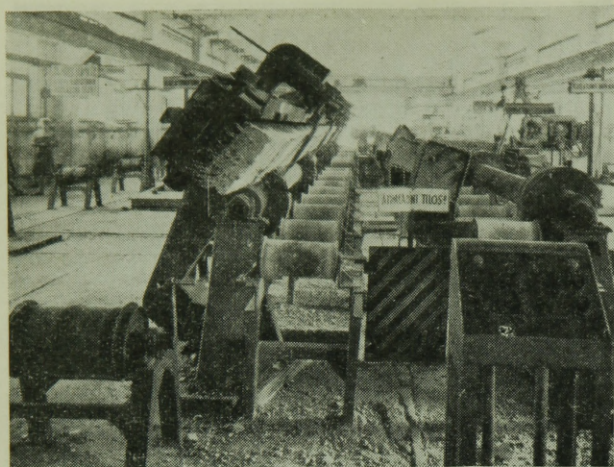
7. ábra. Kiborítógép feszített betonlajak tömeggyártásához
