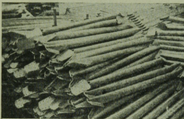
14–17. ábra. A párisi Sportpalota kupolájának elemei, szerelése
