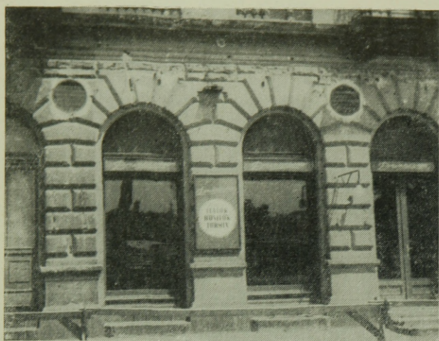
1. ábra. Szellőző nyílások a Vigadó-tér 3. sz. épület dunai oldalán
