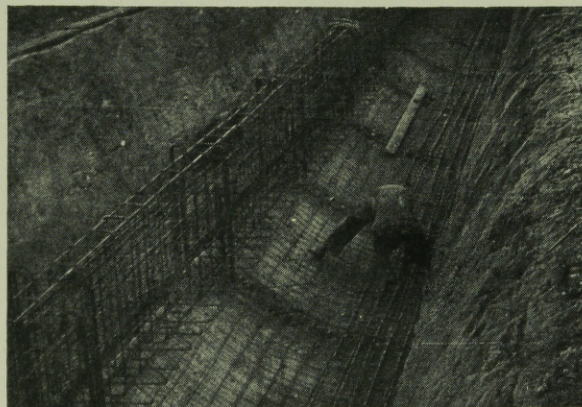
4. ábra. A héjalap vasszerelése
