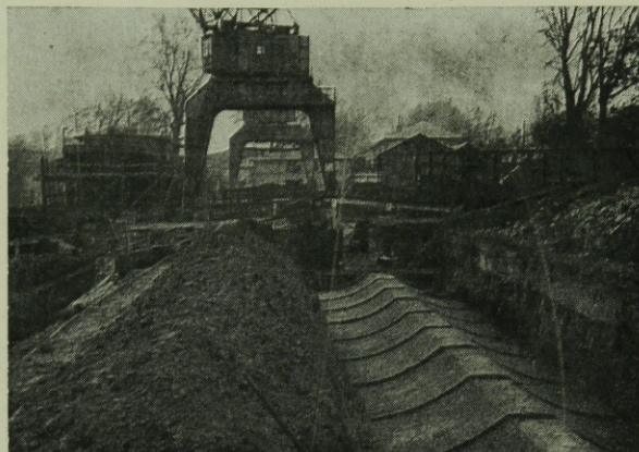
3. ábra. A héjalap szerelőbetonja
