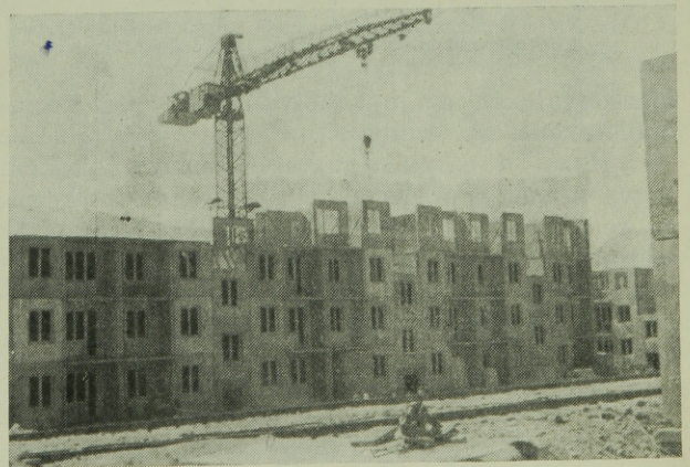
3. ábra. Carns-rendszerű lakóépületek szerelés közben.
