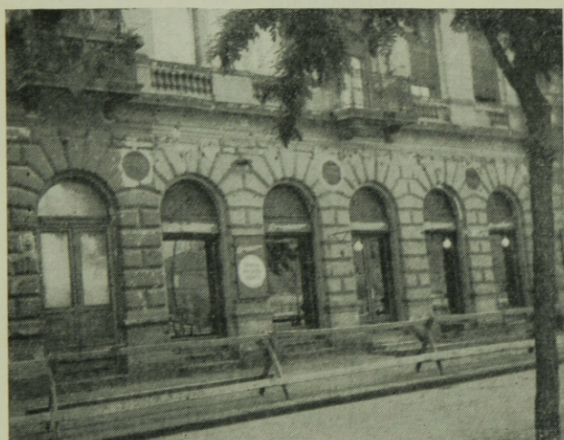
2. ábra. Szellőző nyílások a Vigadó-tér 3. sz. épület dunai oldalán
