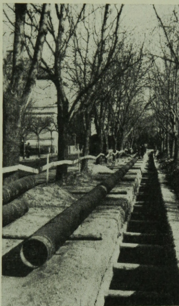
3. ábra. Ideiglenesen kisnyomáson, később középnomásán üzemelő gázvezeték fektetése
