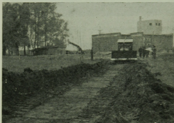
5. ábra. Humuszos talaj vastagságának megállapítása előzetes doservágással
