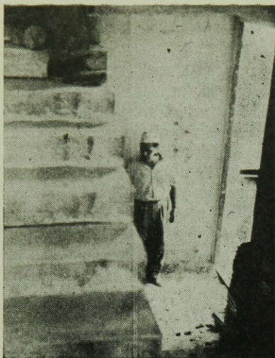
3. ábra. Ez az állapot még nem alkalmas a festő- és mázoló munka megkezdéséhez
