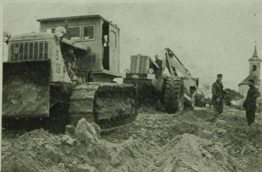
6. ábra. Töltésépítés scräpperrel (a terítés nem egyenletes)
