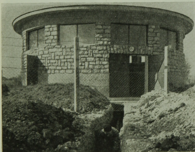
8. ábra. Épület melletti csatornaárok kiemelve, a visszatöltés tömörítése nehezen megoldható
