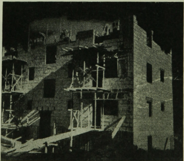
3. kép. Többszintes kézielemekből épített lakóház
