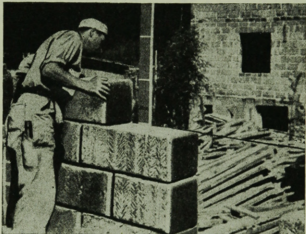
2. kép. Sejtbeton kézielemmel épülő felmenő fal
