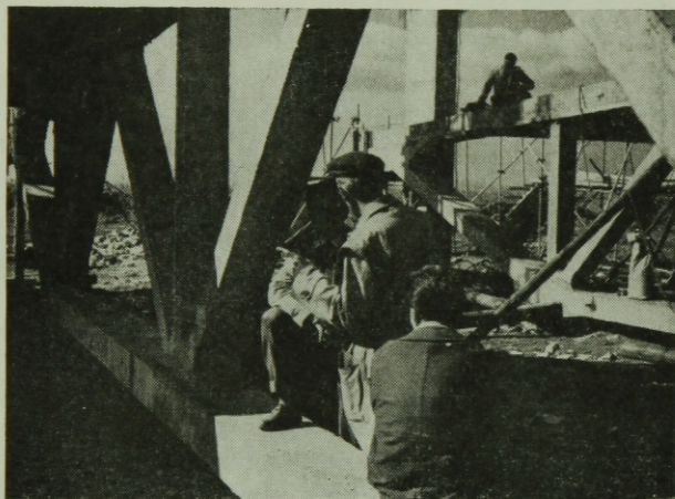
4. ábra. T. V. K. 30 m-es rácsostartója feszítés után
