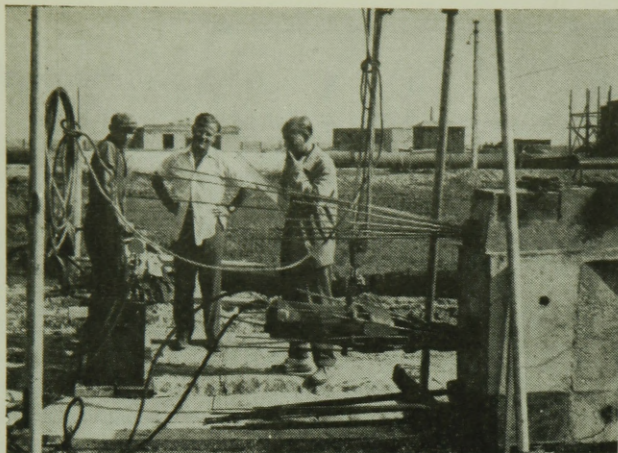
3. ábra. Feszítés a T. V. K. építkezésénél
