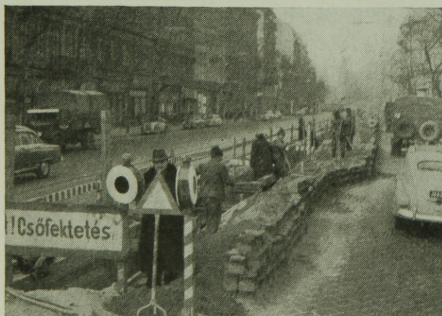
9. ábra. Dúcolt árok kiemelése
