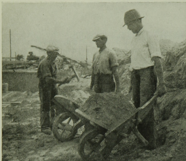
7. ábra. Föld visszatöltés talicskával épület mellé, tömörítés nélkül
