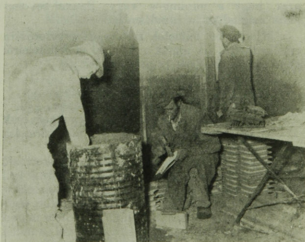
2. ábra. Mázoló munkával egy időben készül a cserépkálya
